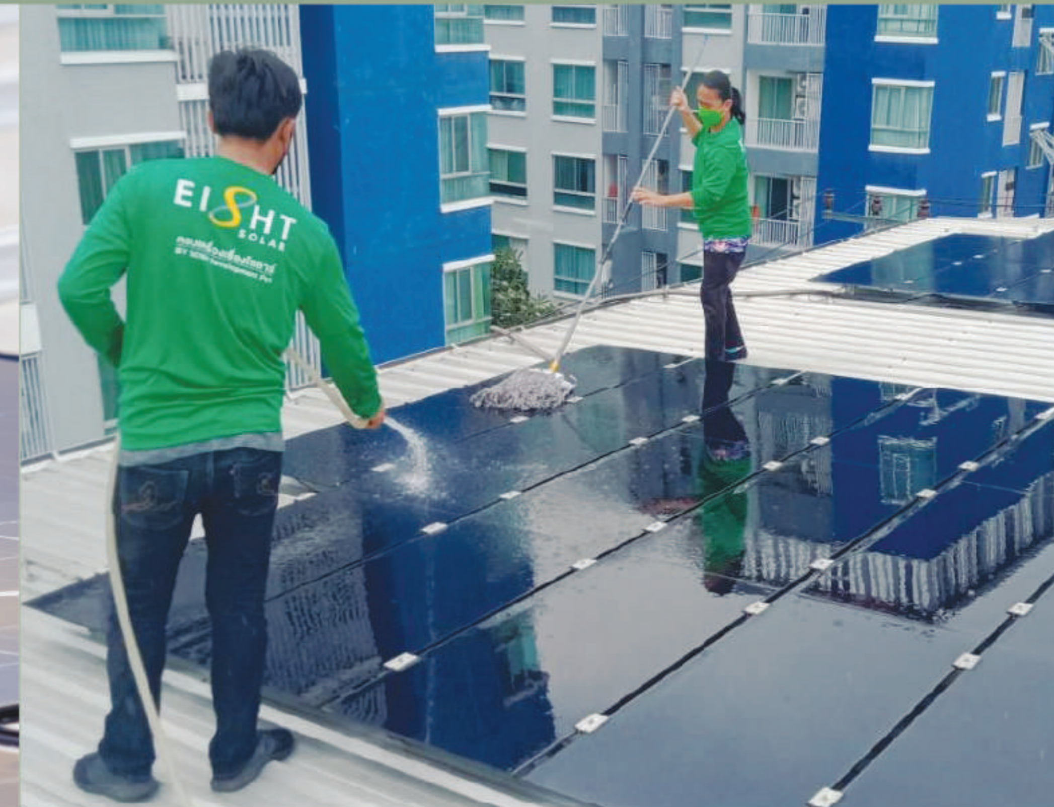
การทำความสะอาดแผงโซลาร์ ทุก 6 เดือน 1 ครั้ง ( ปีละ 2 ครั้ง )
