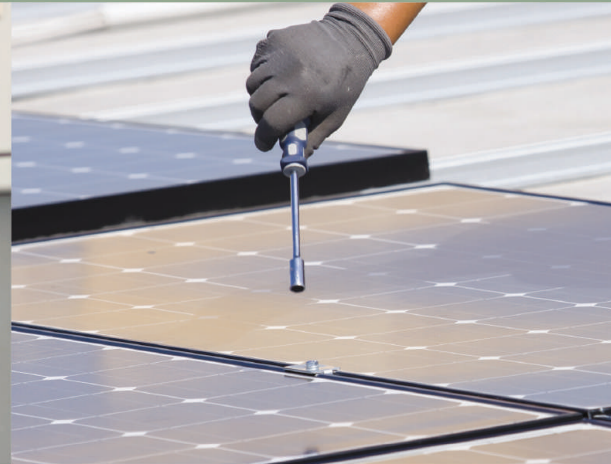
การตรวจสอบอุปกรณ์ติดตั้ง เพื่อความแข็งแรง
